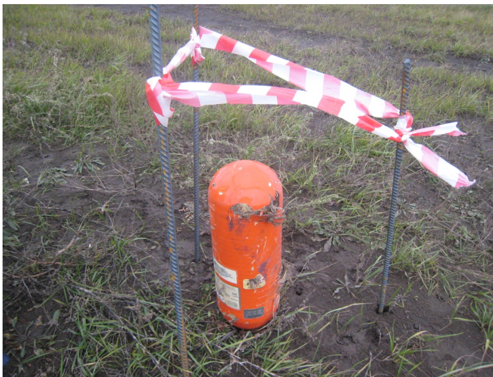
Рисунок 22. Баллон системы пожаротушения
