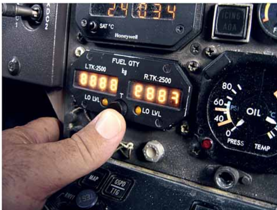
Foto 1: FQI installato sul TS-LBB prima della sostituzione.
