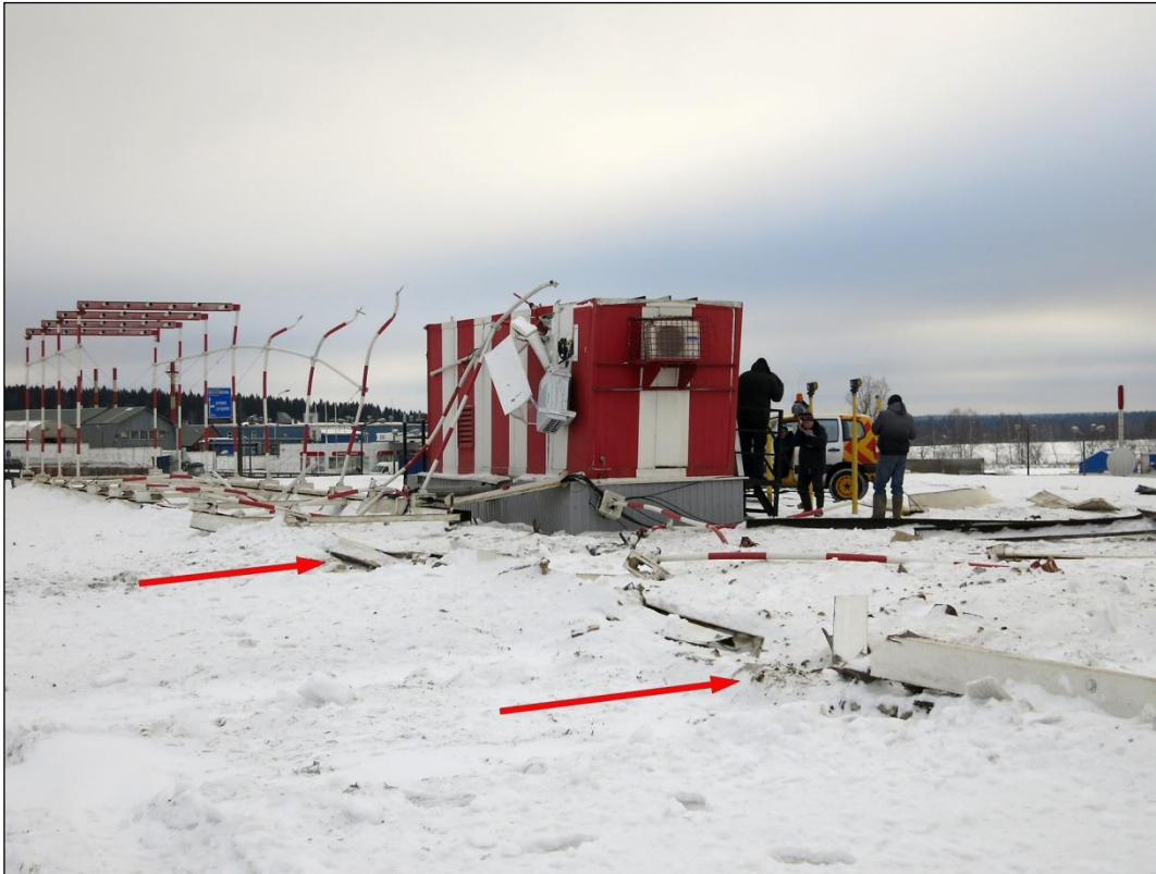
Рис. 5. Место столкновения самолета с антеннами КРМ аэродрома. Стрелками показаны места столкновений колес основных опор шасси с бетонным брусом (высотой около 25 см) и основанием антенн КРМ. Повреждения аппаратной КРМ в результате удара левым полукрылом самолета.
