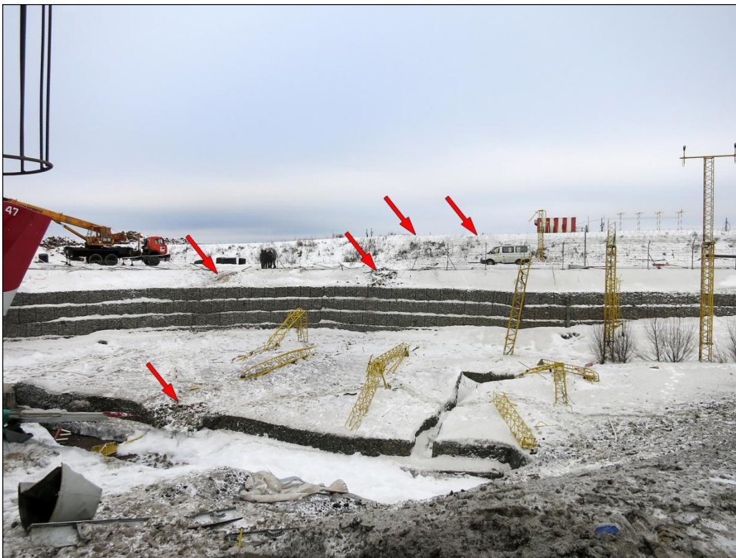
Рис. 6. Следы касания земли основными опорами шасси (отмечены стрелками). Поврежденные и поваленные мачты светотехнического оборудования.
